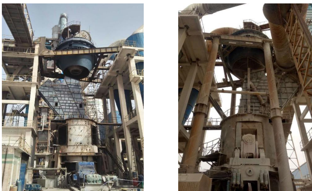
图4 技改施工和运行四个月后的现场图片
