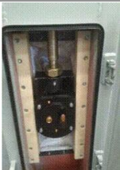
图2 加装软隔断的轴承座
